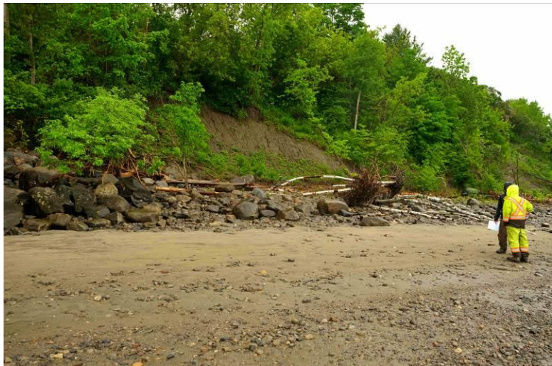
Le talus sollicité est étalé sur le périmètre d'une pointe semi-circulaire (cap Lauzon). La longueur du talus est d'environ 1 000 m.
