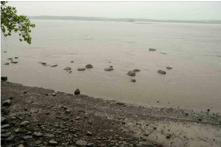
Le secteur à l'étude est localisé au niveau des rapides de Deschambault. La section d'écoulement du fleuve est relativement restreinte, générant des vitesses d'écoulement importantes. Ces conditions hydrodynamiques sollicitent fortement la rive.
