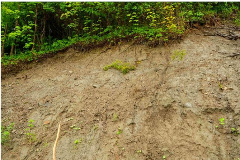
L'érosion du talus progresse de la base vers la partie supérieure. L'inclinaison de la pente suit l'angle de frottement interne du sol en place.
