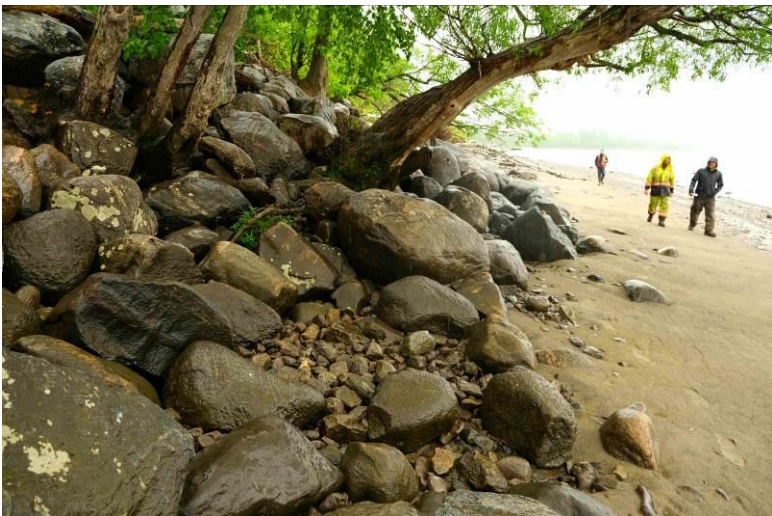
À quelques endroits, on retrouve des amoncellements de roches. Il semble que cette protection soit efficace pour freiner la progression de l'érosion de la falaise.
