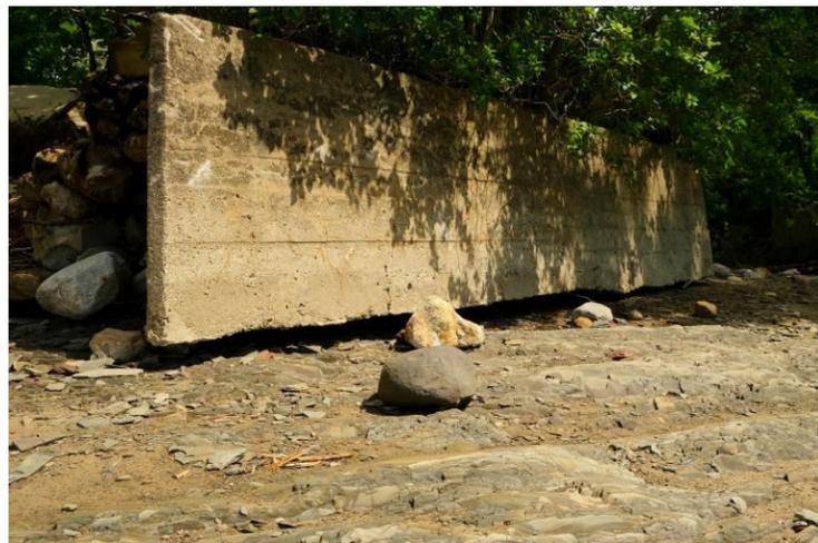
Un des principaux avantages de l'enrochement est la capacité de s'adapter aux changements de la configuration du lit du cours d'eau. Particulièrement, la plateforme du St-Laurent se caractérise par des roches très friables et sensibles au cycle gel-dégel. La protection rigide (murs de soutènement), après quelques années, perd le contact avec le fond et sa stabilité devient compromise.
