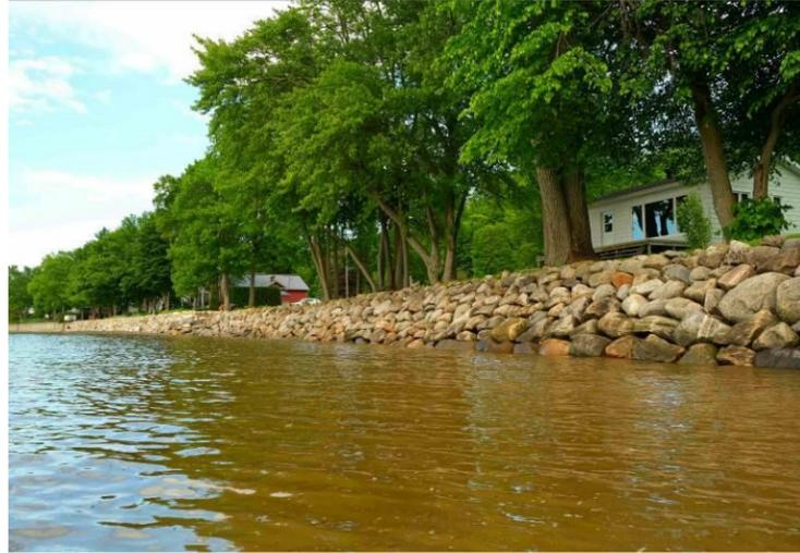
La protection des rives par l'enrochement est la technique la plus fréquemment utilisée pour la consolidation des talus soumis à l'action hydraulique des plans d'eau et des cours d'eau.
