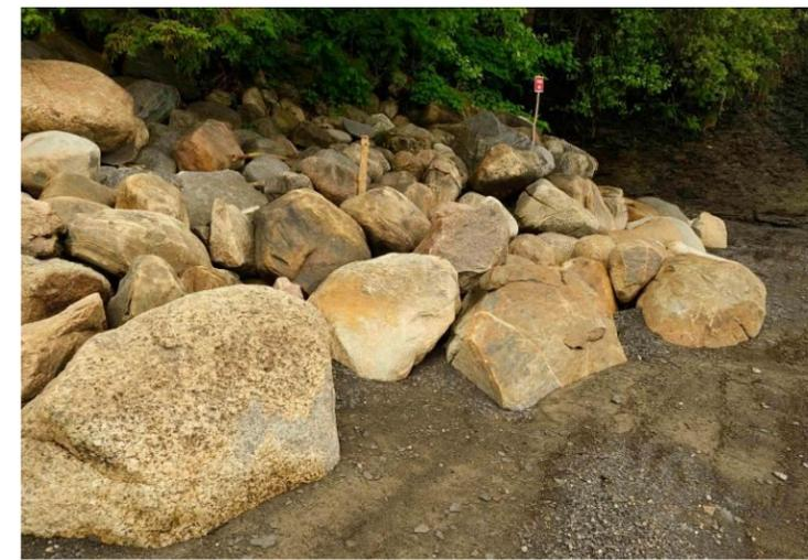
Le calibre des roches homogène et leur forme arrondie est responsable du volume relativement important des interstices. Cette configuration permet aux vagues de lessiver tout matériel plus fin des interstices et de rendre la masse de l'enrochement peu propice à la colonisation par des espèces végétales.
