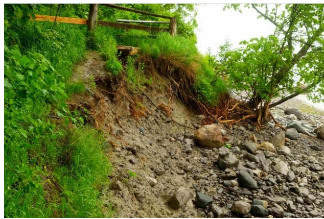
La partie supérieure du talus est consolidée par un couvert végétal.
