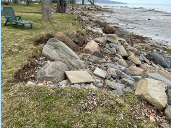
La problématique se situe sur un terrain privé. La rive étaient protégée par un enrochement qui s'est altéré avec le temps et a été comblé avec du matériel divers. L'érosion est encore active sur le terrain et nécessite une intervention à court ou moyen terme. La situation est relativement courante sur le littoral portneuvois.
