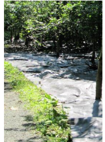
Pose de la membrane
