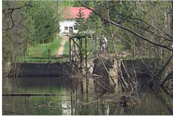
Figure 2.5. Barrage X0002184 de Deschaillons-sur-Saint-Laurent
