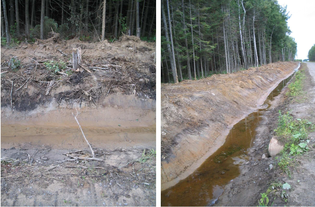
Figure 7.1. Des fossés mal aménagés en milieu forestier
