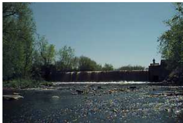
Figure 2.6. Barrage X0002183 de Fortierville
